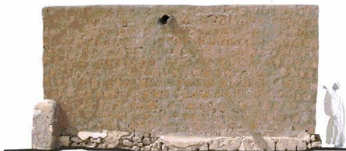
(C) FAÇADE EST
