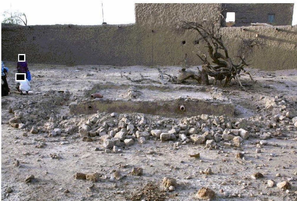
Mausolée Mohammed Boukou : Façade Ouest, évacuation des débris, photo [redacted] 2013
