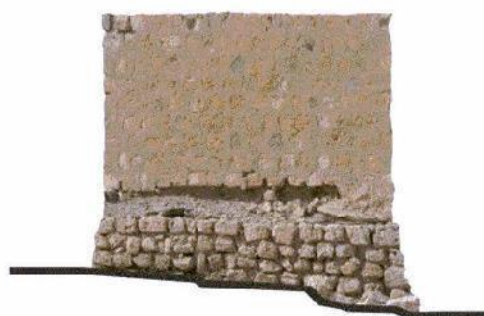
(D) FAÇADE EST
