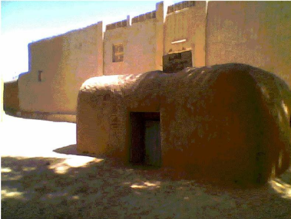
Mausolée de Cheikh Sidi Mohammed Al Foullani Al Macini, photo : Archives DNPC
